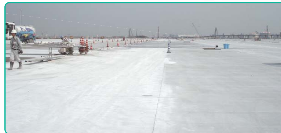
コンクリート舗装完了
