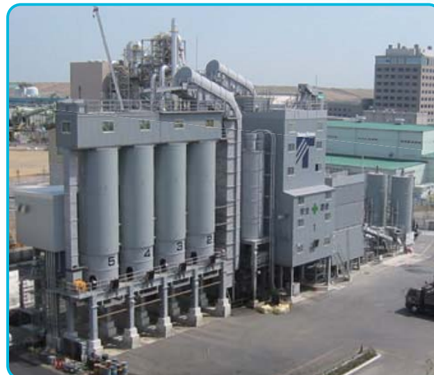
最新鋭の機械が導入されている、東京青海合材工場及び東京リサイクルセンター。ここに道路廃材が運ばれ、新たな舗装材料として生まれ変わります。
