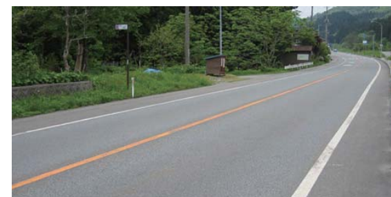
リラクスファルト舗装により、リフレクションクラックが抑制されている舗装
