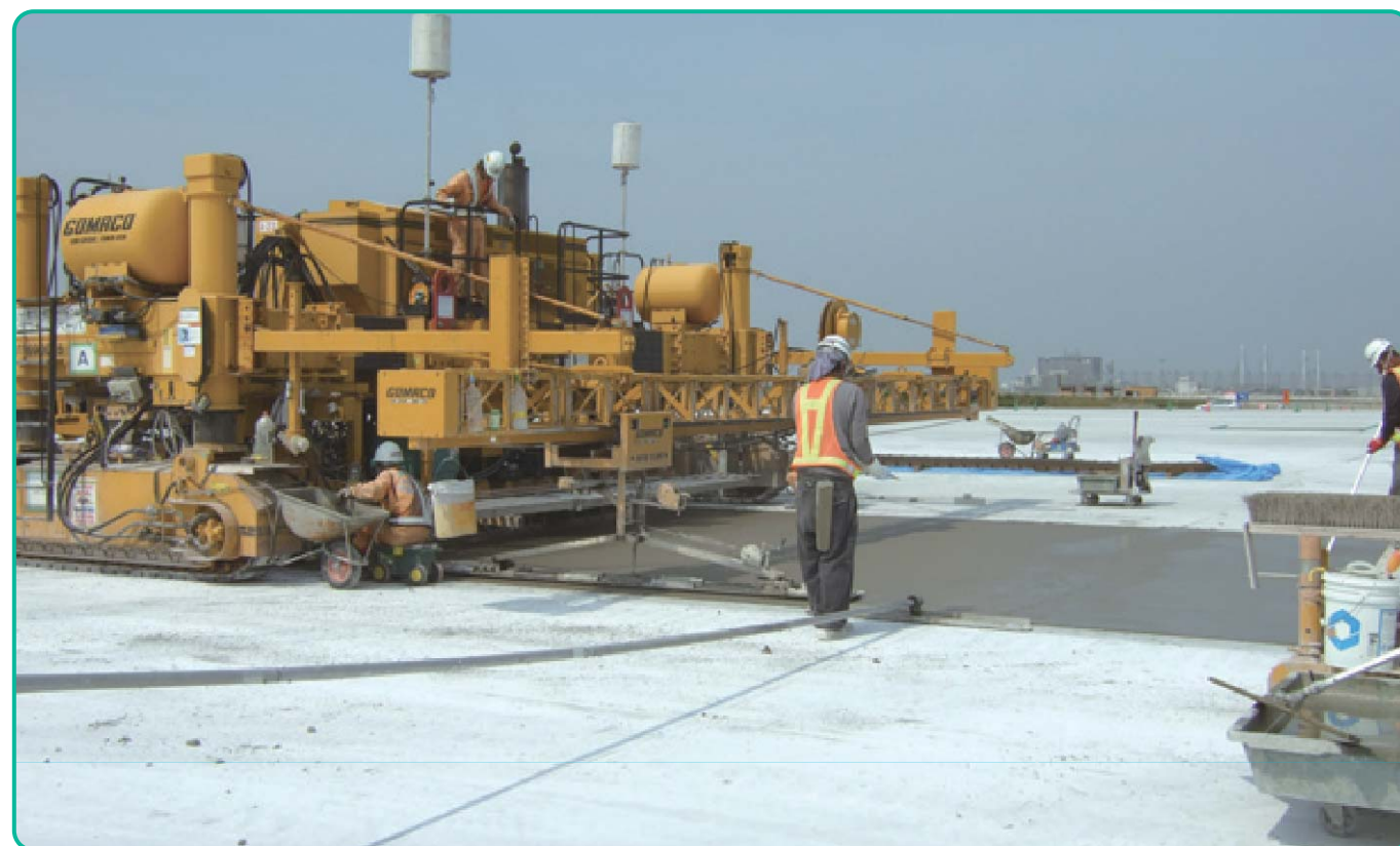
スリップフォームによるコンクリート施工状況
