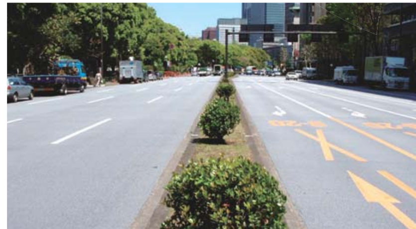
クールウェイ施工例(日比谷通り)
