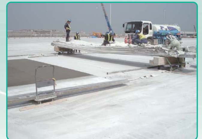
コンクリート養生
