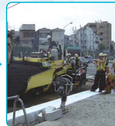
再生され、新たな舗装のために運ばれてきたアスファルト合材が、機械により短時間で敷き均されていきます。
