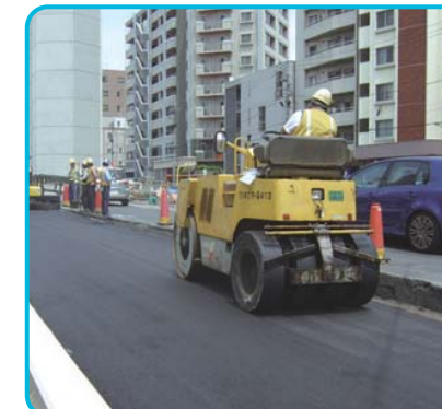
ローラーによる転圧作業。後は路面に白線を引くなどの作業を行って完成です。
