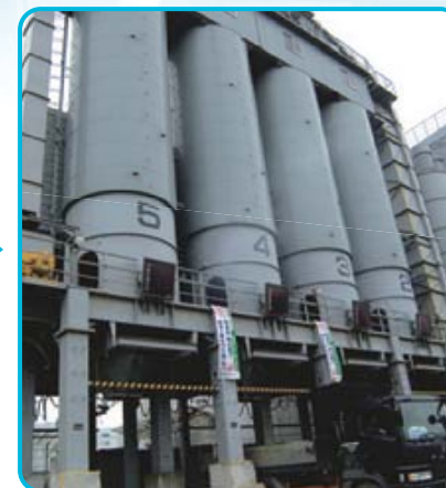
巨大なサイロが並ぶ青海の合材工場。廃材の一部を再利用して作られたアスファルト合材が、舗装現場へ運ばれて行きます。
