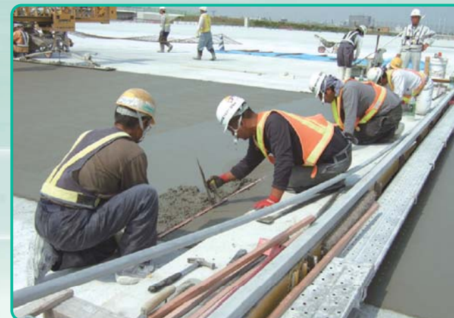
目地入れ作業
