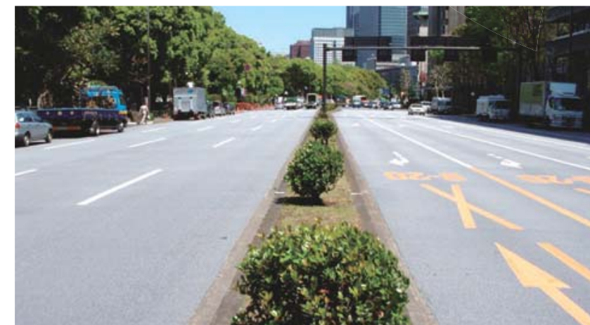
クールウェイ施工例(日比谷通り)
