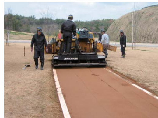
兵庫県 / 三木総合防災公園
