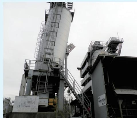
●傾いた合材サイロ。停電により合材が冷えて固まる
