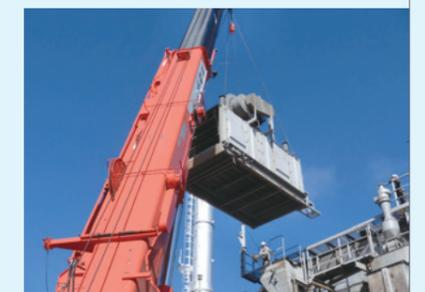
●新規アスファルトプラントの組立て作業(1期工事)
