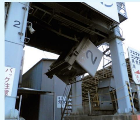
●合材を積み込むミキサ下部ゲートの破損
