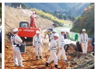
関西支社 丹波綾部道路舗装工事
