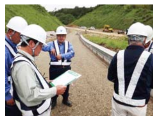
中四国支社 尾道・松江自動車道敷地舗装工事
