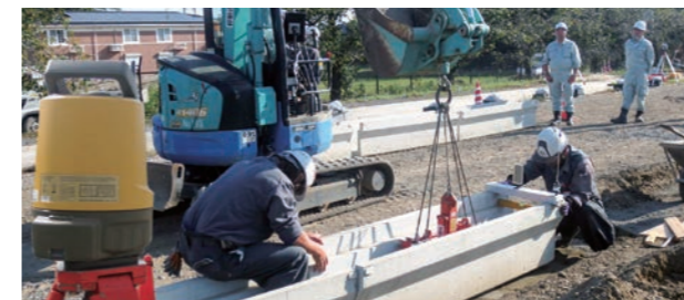
丁張レスでの据え付け作業確認
