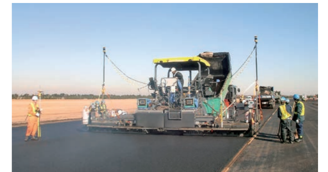
マシンコントロールによる舗装工
