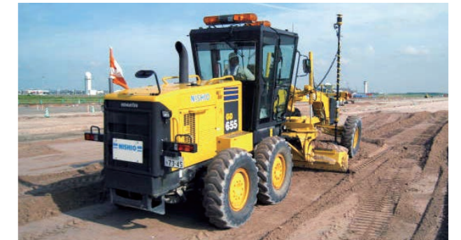
マシンコントロールによる土工
