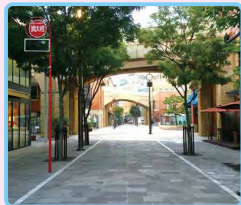
▲チネチッタ通り(神奈川県川崎市)【インジェクト工法】
