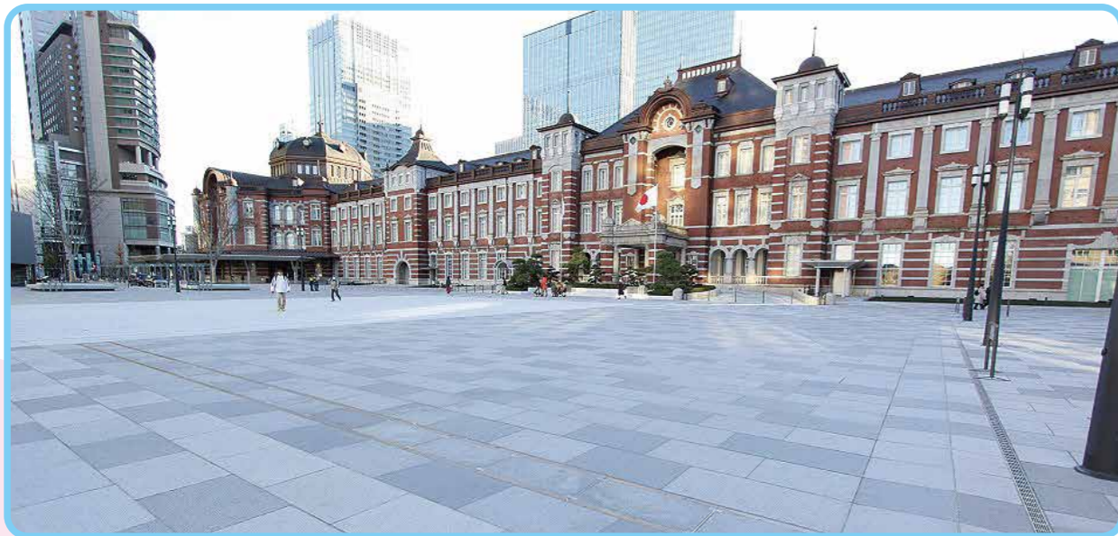
▲JR東京駅丸の内駅前広場(東京都千代田区) 【インジェクト工法】
