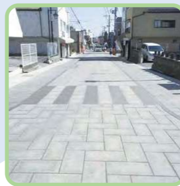
▲一番町大工町線(福島県白河市)【インジェクト工法】
