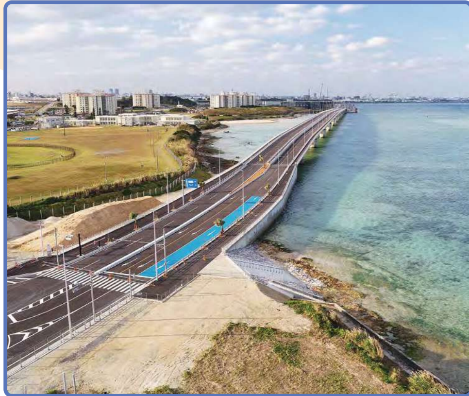
▲那覇港浦添ふ頭地区臨港道路(沖縄県浦添市)
