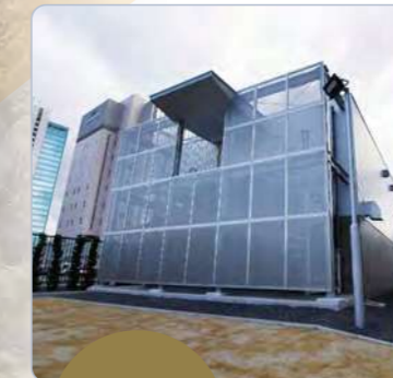
中日美容専門学校防災倉庫 (愛知県名古屋市中)
