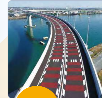
四日市港霞ヶ浦北ふ頭地区道路 (三重県四日市市)
