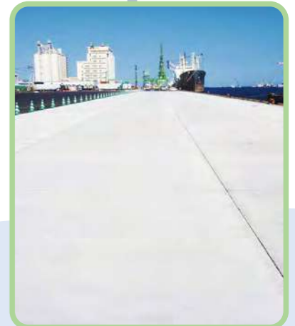
▲仙台塩釜港(宮城県仙台市)
