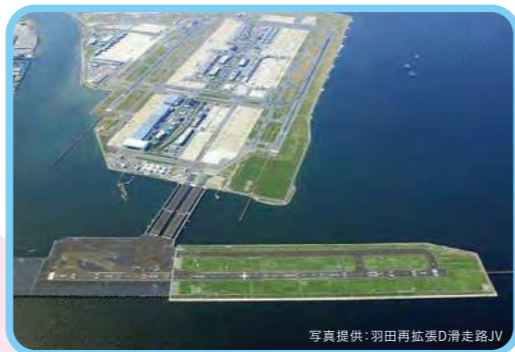
▲羽田空港 D滑走路(東京都大田区) 写真提供:羽田再拡張D滑走路JV
