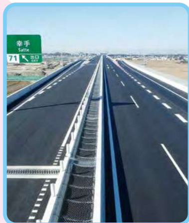
▲首都圏中央連絡自動車道 幸手IC (埼玉県久喜市)
