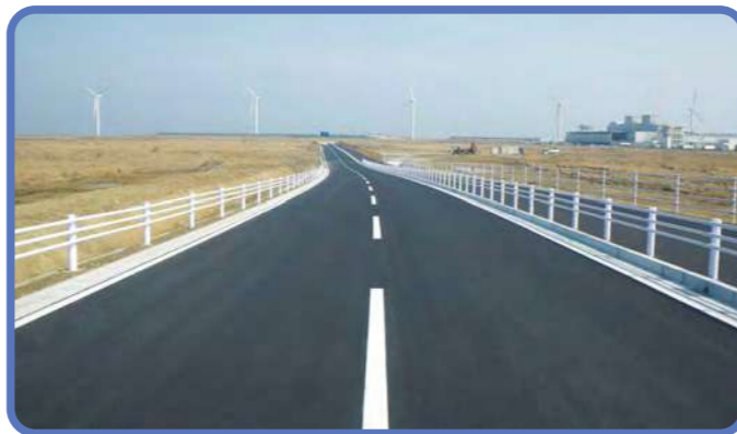
▲北九州港道路(福岡県北九州市)
