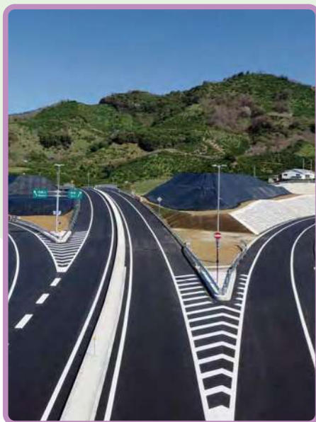
▲紀北東道路 紀の川東IC (和歌山県紀の川市)
