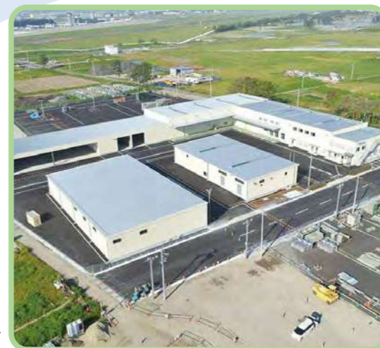
日建リース工業仙台工場 (宮城県名取市)▶
