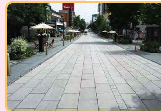
▲善光寺表参道(長野県長野市)【インジェクト工法】
