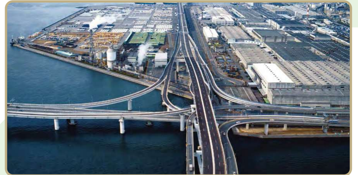
▲広島高速3号線(広島県広島市)
