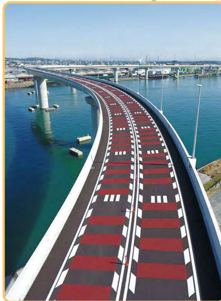
▲四日市港霞ヶ浦北ふ頭地区道路(三重県四日市市)
