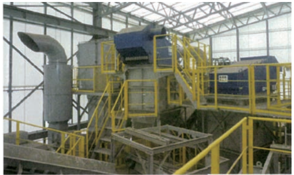
内部：粉塵発生抑制を目的とし、建屋内に破碎設備を設置しています。
