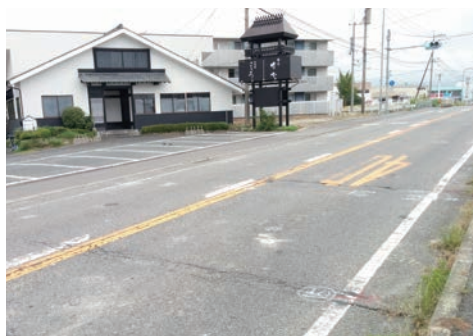
国道（佐賀県）施工前
