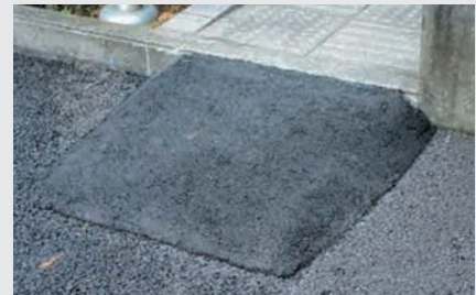
段差すりつけ
