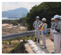
西日本豪雨で被災した国道31号・185号呉保守工事社長パトロール
