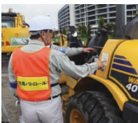
東京国際空港国際線地区構内道路舗装工事社長パトロール
