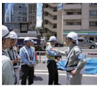
(負)環状6号線西五反田地区および下目黒地区街路築造工事社長パトロール
