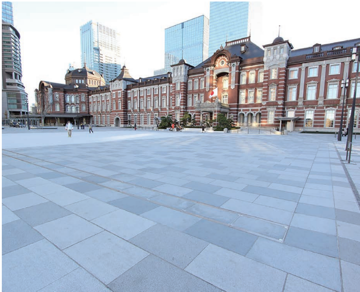
JR東京駅丸の内駅前広場（東京都）／インジェクト工法（石張り舗装）
