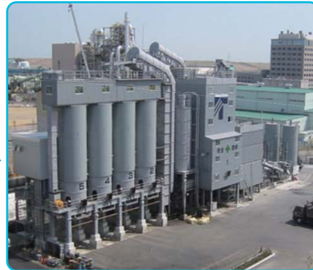
最新鋭の機械が導入されている、東京青海合材工場及び東京リサイクルセンター。ここに道路廃材が運び込まれ、新たな舗装材料として生まれ変わります。
