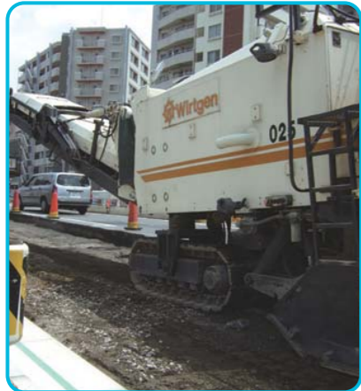
道路表面の老朽化したアスファルト舗装を機械により短時間で取り除いていきます。
