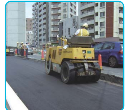
ローラーによる転圧作業。後は路面に白線を引くなどの作業を行って完成です。
