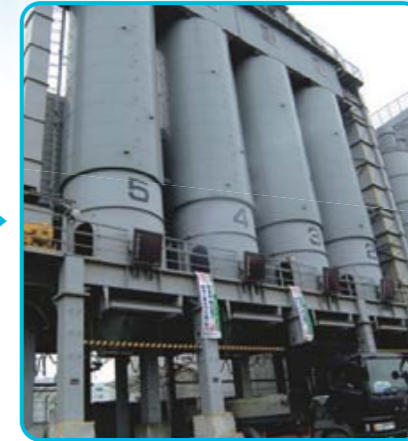
巨大なサイロが並ぶ青海の合材工場。廃材の一部を再利用して作られたアスファルト合材が、舗装現場へ運ばれていきます。
