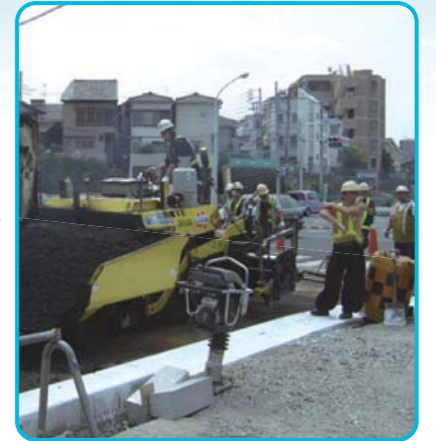
再生され、新たな舗装のために運ばれてきたアスファルト合材が、機械により短時間で敷き均されていきます。
