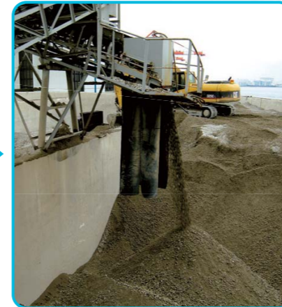
廃材がリサイクルセンターで再生され、アスファルト合材の一部として使用されます。
