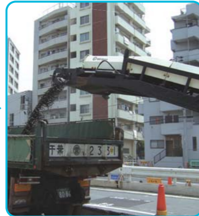
削り取られた廃材は、トラックに積み込まれ、リサイクルセンターに運ばれます。
