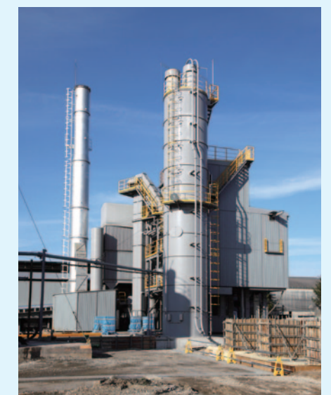
●新規アスファルトプラントの組立て作業(1期工事)
