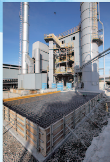
● 合材サイロ基礎工事
