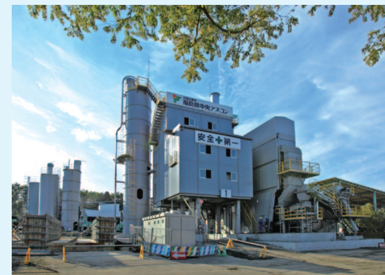
●復旧した出荷ゲート
