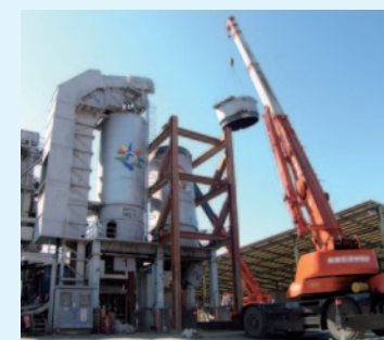
●合材サイロの解体・撤去作業
