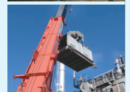
●新規アスファルトプラントの組立て作業(1期工事)
