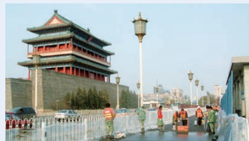
北京市前門の舗装工事の様子
