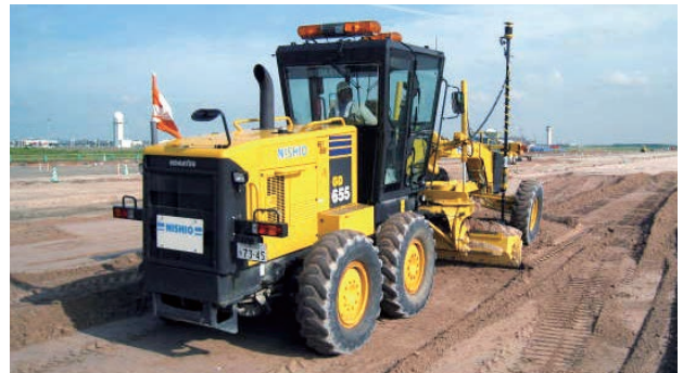
マシンコントロールによる土工
