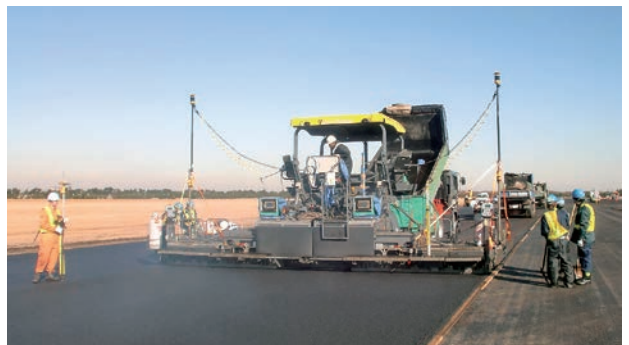
マシンコントロールによる舗装工
