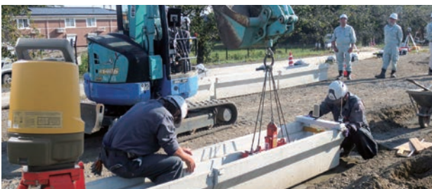
丁張レスでの据え付け作業確認
