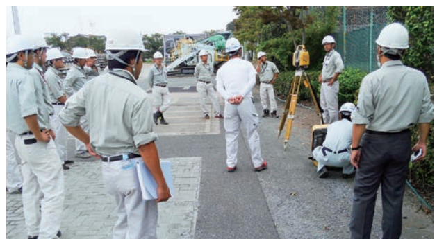
工事社員を中心としたICT研修
