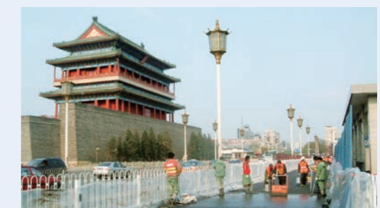
北京市前門の舗装工事の様子
