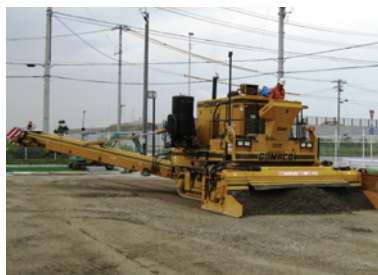
【路盤施工状況】
