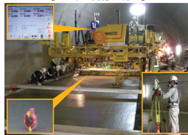
【トンネル内部の施工】
