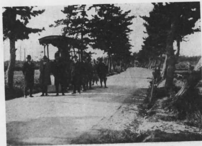
愛知縣愛知郡豊明村地内(東海道)エマルビア渗透マカダム鋪装 (昭和五年十月弊社施工)
