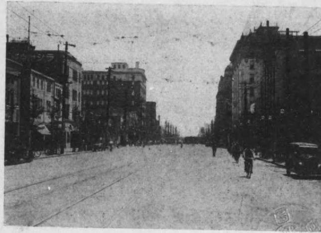
東京市京橋交又點附近シートアスファルト(76耗)鋪装 (昭和四年六月弊社施工)
