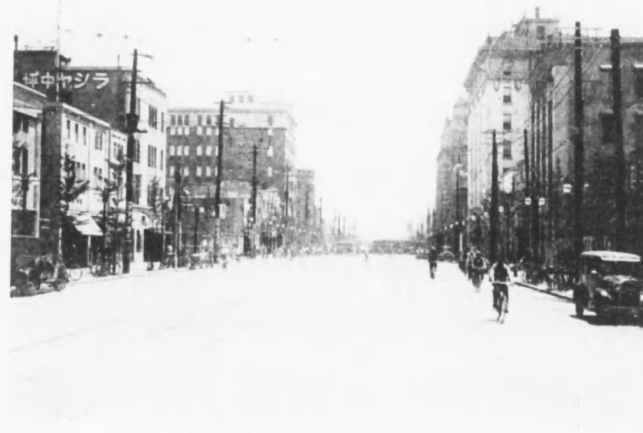
東京市京橋文京點附近シートアスファルト（74年）舗装 （昭和四年六月弊社施工）
