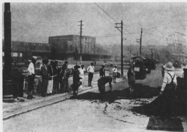
横浜驛前、トベカ式アスファルトコンクリート施工中ノ光景 (昭和五年五月弊社施工)
