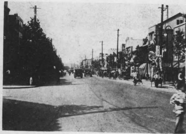
東京市芝區新樓田町通シートアスファルト(76耗)鋪装 (昭和四年八月弊社施工)
