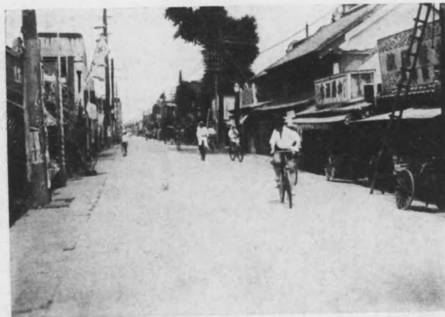
中仙道、埼玉縣浦和町、在來砂利道上に施工せるトベカ式アスファルトコン クリート(50耗)舗装 (昭和四年十月弊社施工)
