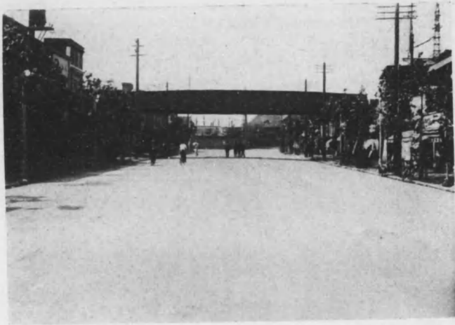
東神奈川驛前通軌道敷、ブラックベース(60耗)、トベカ式(30耗)舗装 (昭和五年五月弊社施工)
