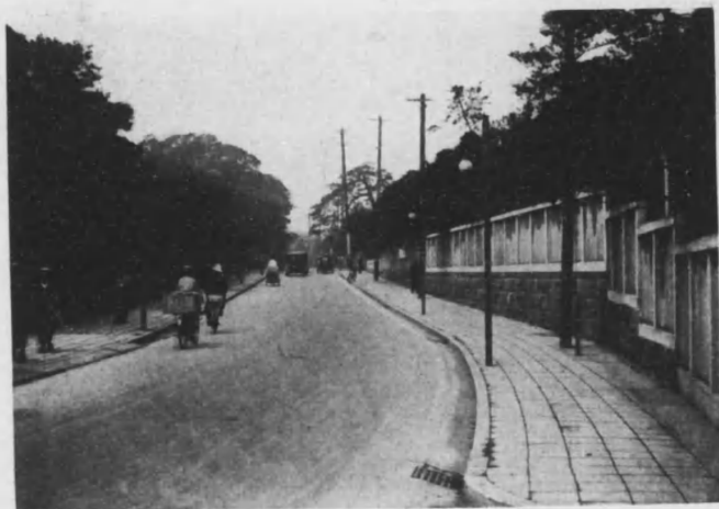
東京市下谷區上野寛永寺橋附近トベカ式アスファルトコンクリート(50耗)鋪装 (昭和二年七月弊社施工)
