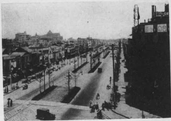
東京市昭和通歌舞伎座附近幹線第一號道路シートアスファルト(76耗)鋪装 (昭和四年十二月弊社施工)
