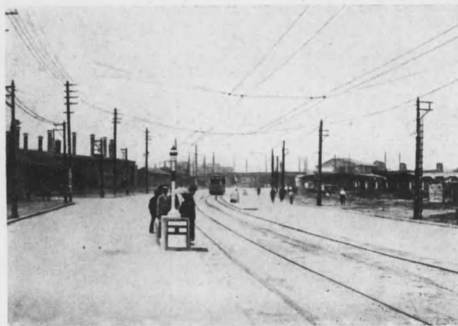
横浜市高島驛前、トベカ式アスファルトコンクリート(50耗)鋪装 (昭和五年五月弊社施工)
