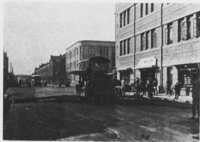
熊本市勸業館附近在來路盤上に施工せるシートアスファルト舗装 (昭和六年十月弊社施工)
