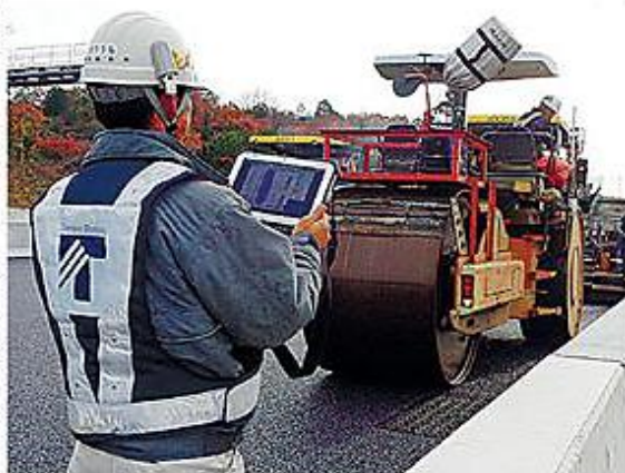
新東名高速道路豊田舗装工事で適用
