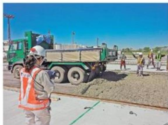
三沢市で三沢空港の駐機場部のコンクリート舗装工事に導入し、打設前の適切な配車や施工速度の調整、コンクリートの可使時間の確認などに使用している。また、コンクリートの品質管理試験の結果を工程ごとにウェブサーバーに保存してコンクリート打設日報や各種品質帳票を出力できるため、現場担当者の負担軽減も期待されている。
