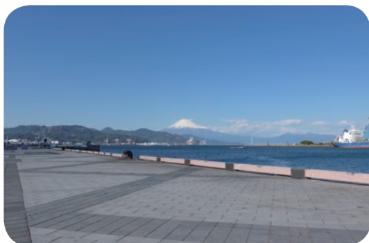
清水港 静岡県(インジェクト工法)
