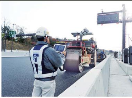
転圧管理システムの導入状況
