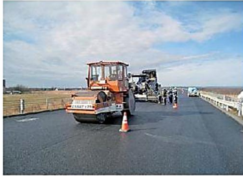
ハイパーマスタックの施工状況
