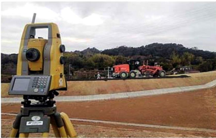
現場での施工の様子
