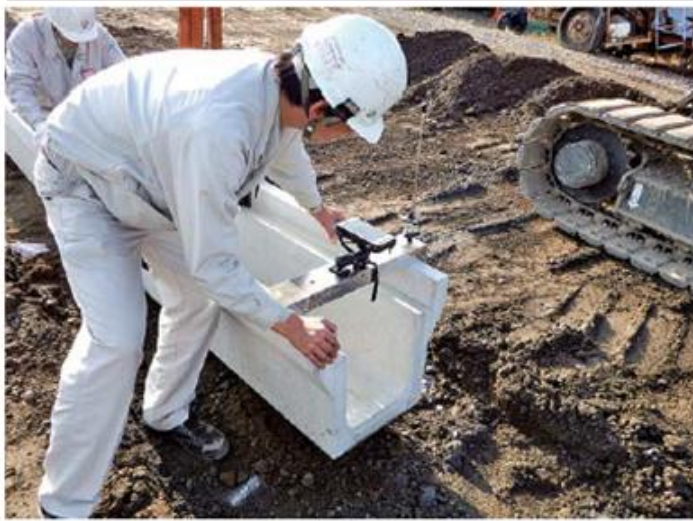
丁張りなしで据え付け作業を実施
