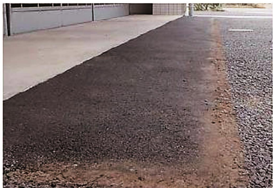
試験施工を実施した箇所
