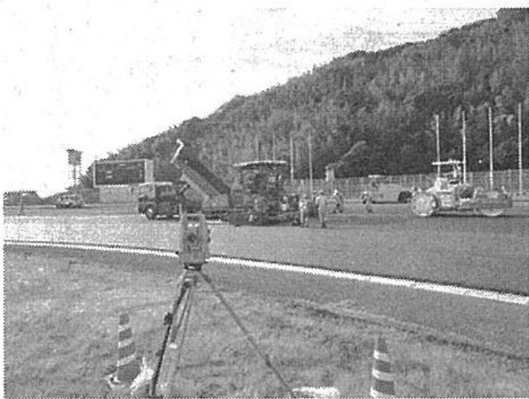
自 動 追 尾 式 T S に よ る 敷 き 均 し 制 御 状 況
