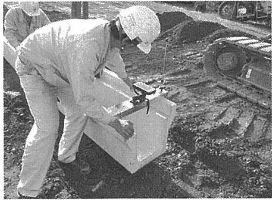
専用測量ソフトを使用した施工
