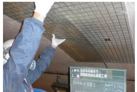
FRPメッシュによるトンネル天井部の剥落防止
