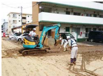
汚泥除去作業の様子
