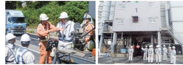
東名高速道路 豊田管内舗装補修工事 全国安全週間に実施された東京青海合材工場社長パトロール
