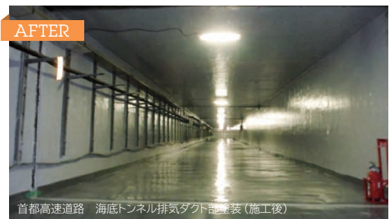
首都高速道路 海底トンネル排気ダクト部塗装 (施工後)
