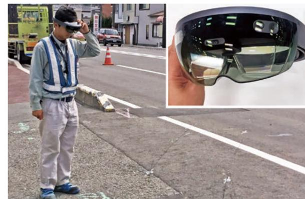
HoloLensによる埋設管の確認状況
