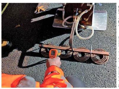
び割れを加熱で 修復する様子 自己治癒アスフ ァルト舗装のひ
