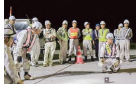
東京国際空港東側整備地区 エプロン他舗装改良工事
