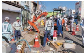
現場パトロールの様子
