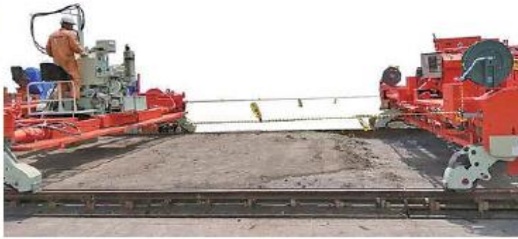
くるくるトラロープを使った立ち入り制限の様子
