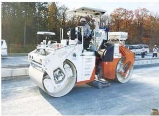
走行しながら締め固め度を自動計測する
