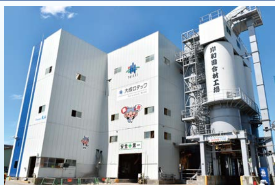
岸和田合材工場／大規模改修
