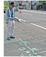
ホロレンズによる埋設管の確認状況
