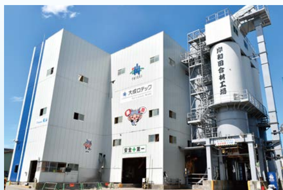
岸和田合材工場／大規模改修
