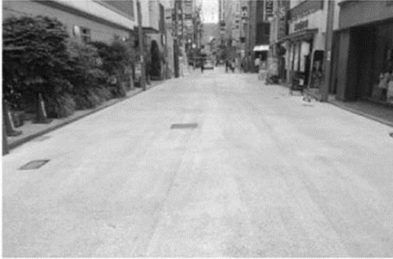
大成ロテック中国支社は、広島市の中心地にある中の棚商店街の石畳をリニューアルする舗装工事を受注し、現地で作業を進めている。写真。四半世紀前に整備された自然石舗装とピンコロ石(御影石)で構成された舗装を半たわみ舗装に改修する。中の棚は、広島の都心である八丁堀に近く、相生通りや本通・金座街に囲まれた縦横5本の
