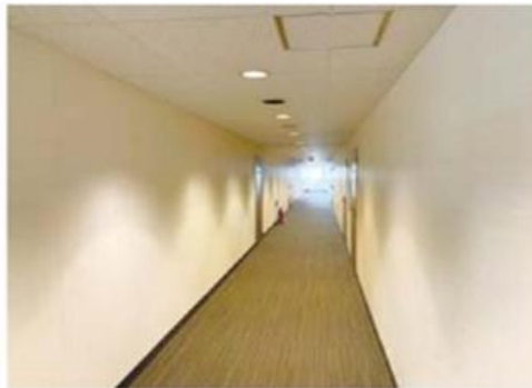
改修前の廊下
