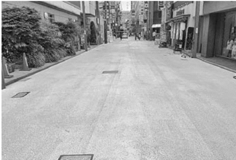
ロ石の舗装を半たわみ舗装に改修する。舗装は赤みがかった風合いで、江戸時代の赤御影石と、カッター目地による大判の石を連想させるイメージを踏襲した。
