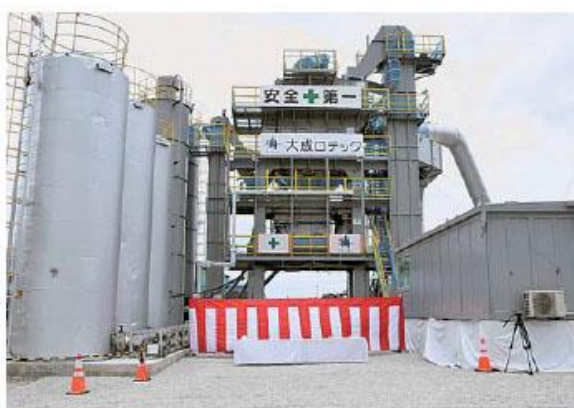
完成したアスファルトプラント
