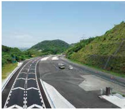
本工事は、南阪奈道路の太子IC～葛城IC間の交通事故対策を目的とした付加車線設置事業に伴う舗装工事です。当該区間は、暫定2車線で供用されていましたが、設計基準交通量を遥かに超える交通量で、対面通行である竹内トンネル内での重大事故発生などのリスクがあることから、早急な4車線化が求められていました。2020年2月からII期線の暫定供用となり、2020年7月に完全4車線供用を開始しました。
