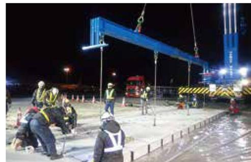
鹿児島空港誘導路(P-4)の老朽化した既設コンクリート舗装版を撤去し、高強度PRC舗装版を設置する誘導路改良工事を行いました。航空機運航の安全性を確保するために高い施工精度を求められる現場でした。
