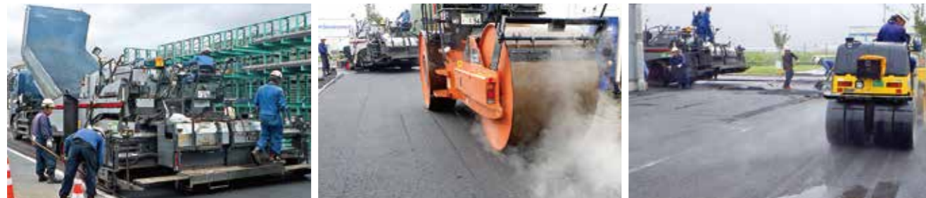
TRタフペイブ構内舗装の施工
