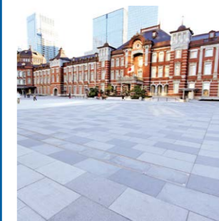
JR東京駅丸の内駅前広場
