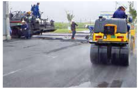
TRタフペイブ構内舗装の施工
