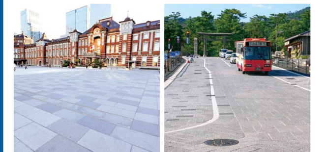
JR東京駅丸の内駅前広場
