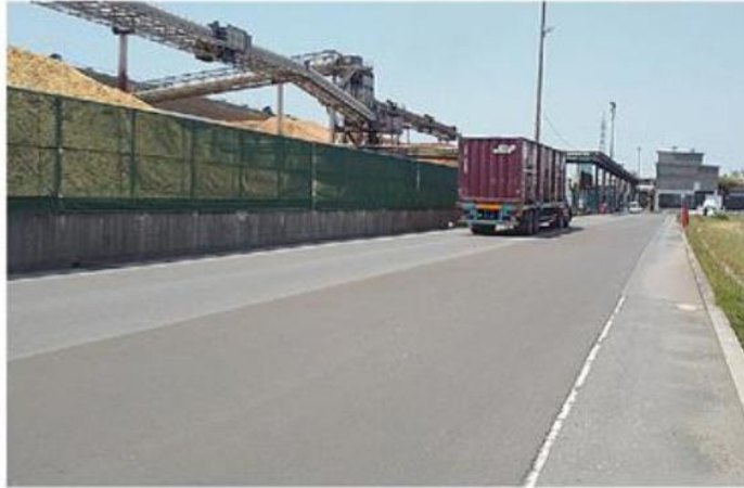
右車線が供用15カ月後の様子 （大成ロテック提供）
