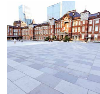
JR東京駅丸の内駅前広場
