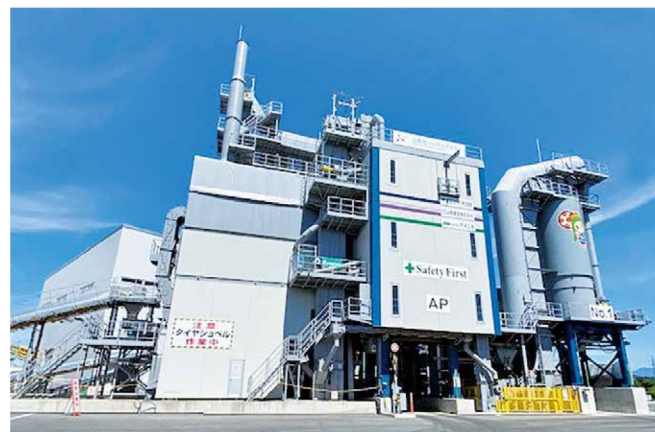
アスファルトプラント(山形工場)
