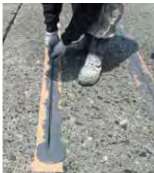
〈フラットバー挿入状況〉
