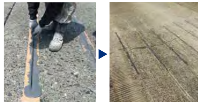
〈フラットバー挿入状況〉
