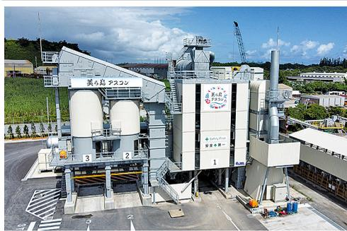
機器の採用と稼働効率化を旨とする省エネ型アスファルトプラント設計を採用。合材製造の燃料をA重油からカーボンオフセットLPGに転換し、中温化（低炭素）合材製造装置の導入やグリーン電力への転換、事務所
